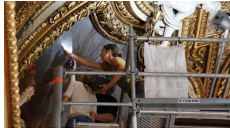
Travaux de conservation préventive dans la galerie d'Apollon
